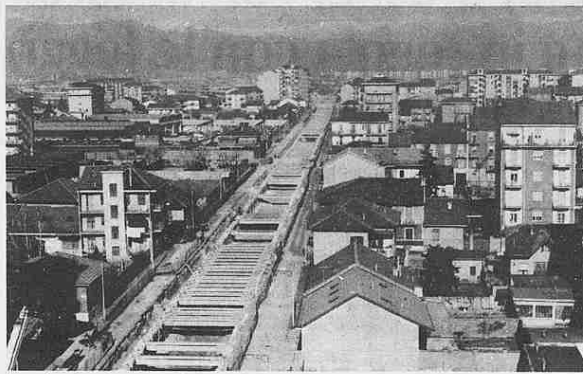
Il tratto già quasi completamente coperto fra la stazione Dora e via Duemila della To-Ceres, futura «metropolitana» per l'aeroporto
